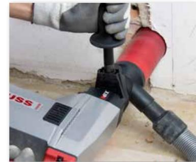
Dosenenken mit Absaugung in hochverdichteten Kalksandstein und Mauerwerk. Hand- oder ständergeführt, je nach Materialbeschaffenheit mit oder ohne Softschlag.
